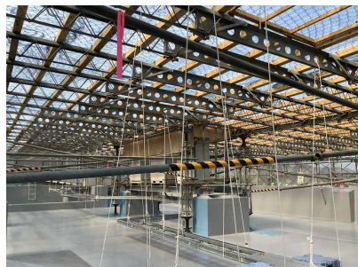
強風に対する強度や盛替え手間など様々な要因を考慮し「全天候型屋根養生(ペコビーム式)」にて施工
