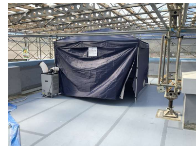
テントとスポットクーラーを組み合わせた簡易休憩所
